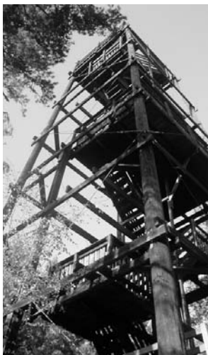
Tornet i Skekarsbo har renoverats under hösten.
