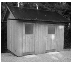
Parkförvaltningen har byggt ett nytt dass som ger kompostjord.
