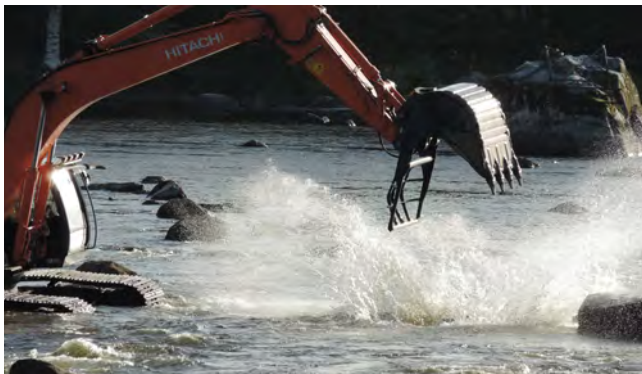
Med hjälp av grävmaskin flyttas stenar till nya platser.
