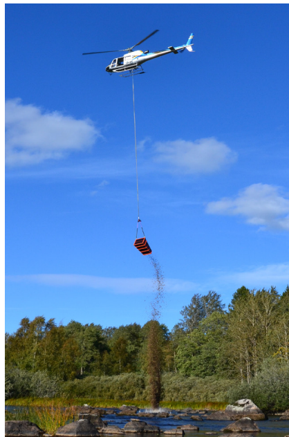
Helikopter lägger ut lekgrus åt strömlevande fiskar. Foto: LIV-projektet.
