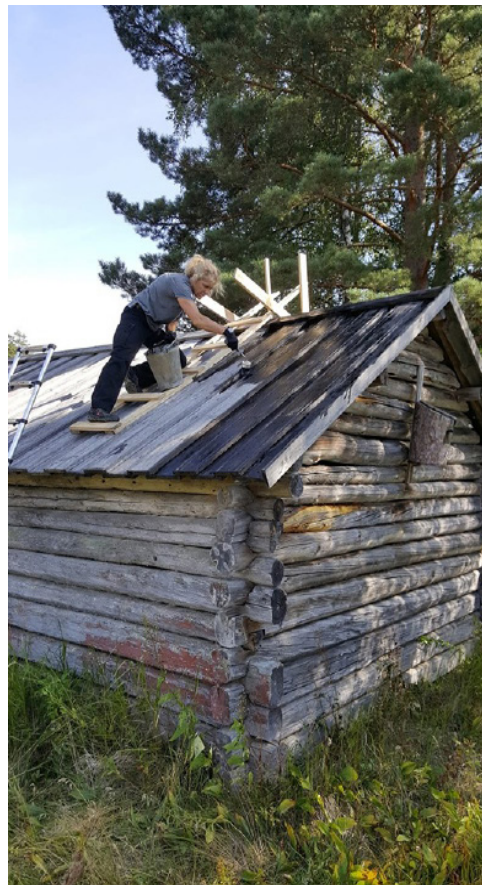
Taket på ladan vid Åsbyvallen tjäras.
