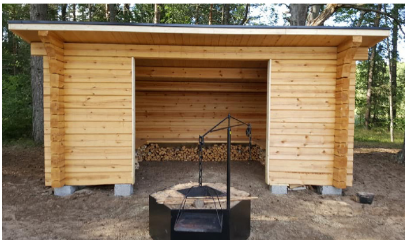
Nytt tillgänglighetsanpassad vindskydd vid Strångnäs.
